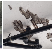
TRATAMENTO DE FERRAGEM
