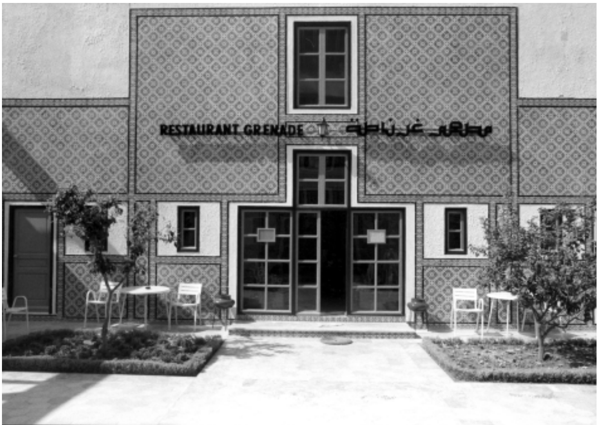
Façade du restaurant sur le patio de l'accueil, seule façade entièrement recouverte de faïence.
