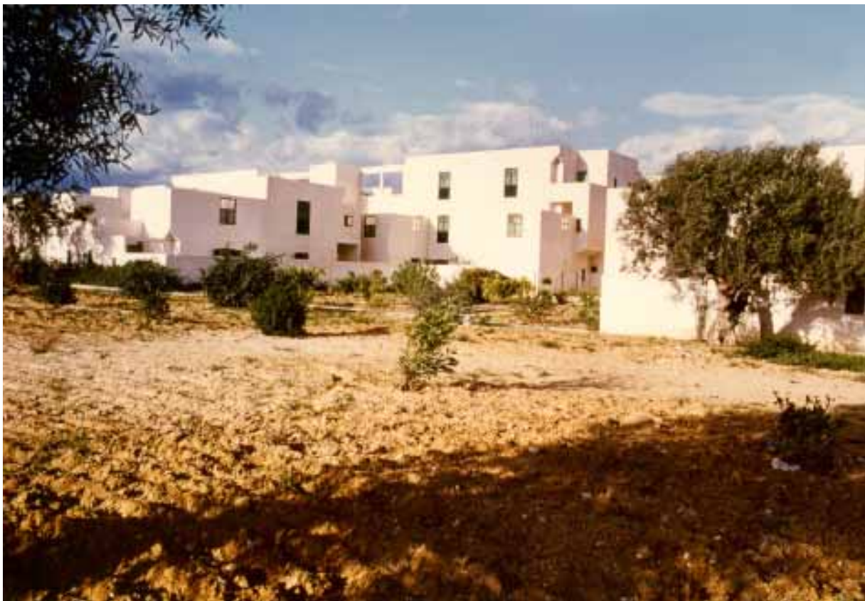
Façade extérieure sur l'un des blocs latéraux
