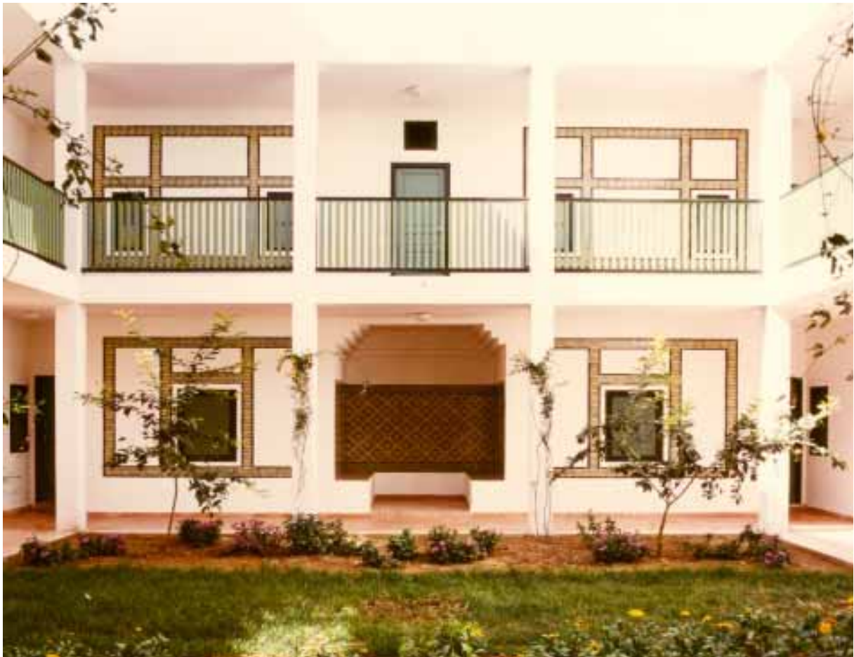
Façade des chambres sur patios-jardins - Les bandeaux de céramique complètent et animent l'architecture.
