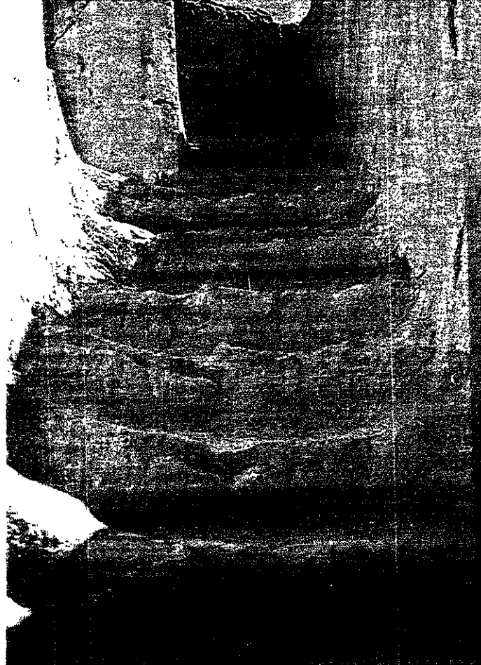
شكل (١٣) طريقة تشطيب درج السلم بلياسة من الطين والطفلة
