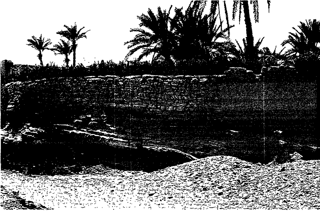
شكل (٣) إنشاء الحوائط بدون استخدام الأساسات في الأرض الصلبة فوق الهضبة (الوحدات البحرية)
