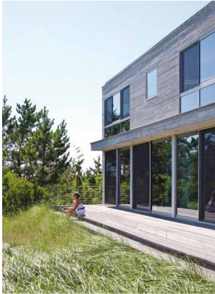
Aus Naturschutzgründen steht das neue Haus auf Fundamenten des alten Baus.
