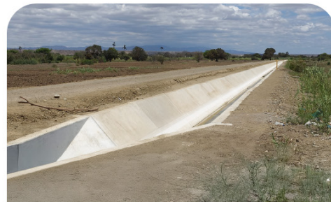
OBRA CANAL DE RIEGO SANTA ELENA PAITA - PIURA
