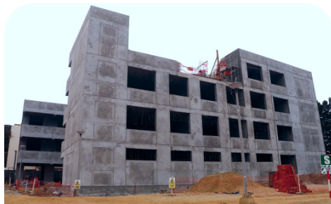
OBRA FACULTAD DE TURISMO UNIVERSIDAD DE CAÑETE CAÑETE - CAÑETE
